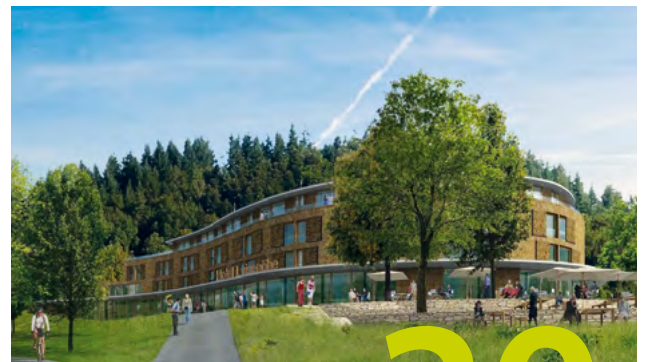
Luisenhöhe Horben: Ökologische Wärme- und Kälteversorgung basierend auf Wärmepumpen mit maximaler Systemeffizienz.
